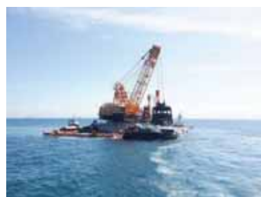
浚渫工事(宇部港)
