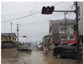
令和2年7月豪雨 において滅灯した信号機
