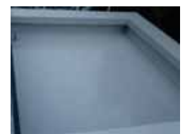
浴室棟屋上(施工後)
