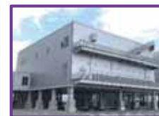
電気設備の地上化
