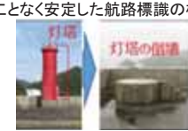
(H30.9名瀬港西防波堤灯台)
