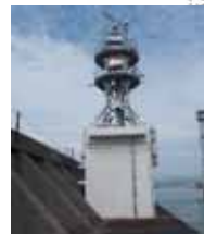
①四日市防波堤信号所 （工期短縮の取組事例）
