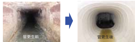
緊急度Ⅰ判定となった管路施設の対策状況（令和4年度）
