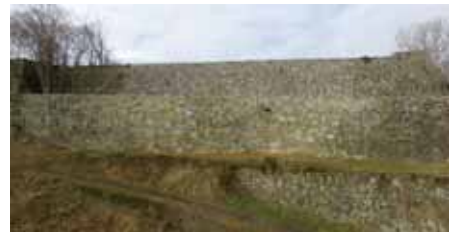
老朽化対策工事完了
