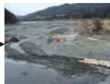
堆砂除去の様子（長野県 美和ダム）
