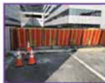
大型止水板の設置
