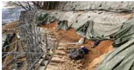
老朽化対策工事
