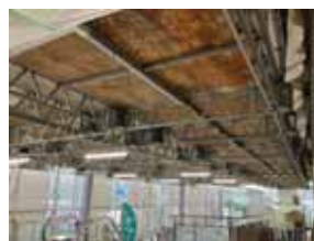
工事中(吊り天井)
