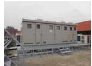
対策後(屋上階)
