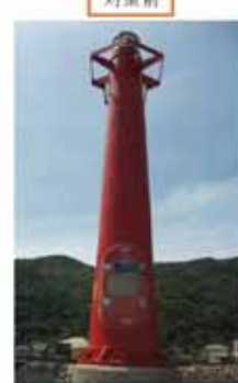
四浦港深良津防波堤灯台
