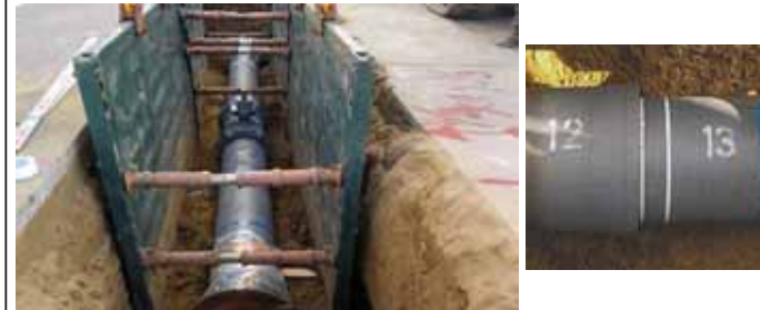
耐震管の布設工事状況
