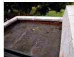
浴室棟屋上(施工前)
