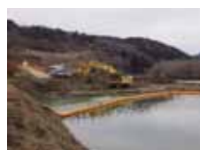
堆砂除去の様子（京都府 天ヶ瀬ダム）
