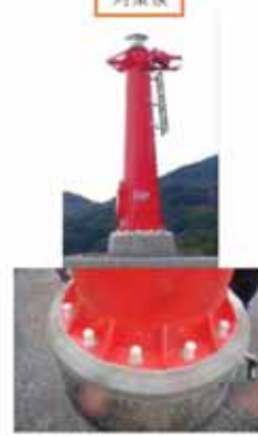
遮断措置を実施したアンカーボルト
