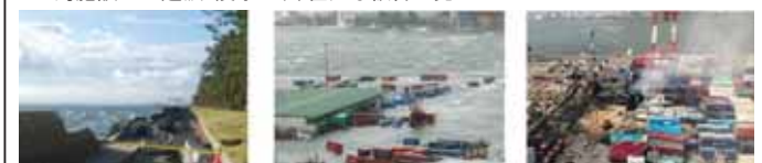
越波による護岸の倒壊 浸水による蔵置コンテナの流出 浸水によるコンテナ火災
