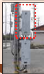
リチウムイオン電池式 自動起動式 (整備例:鳥取県)(整備例:大分県)
