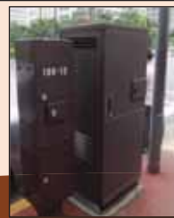
リチウムイオン電池式 自動起動式 (整備例:鳥取県)(整備例:大分県)
