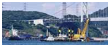
浚渫工事(関門航路)
