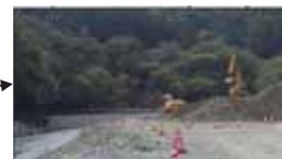
堆砂除去の様子（北海道 金山ダム）
