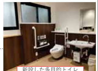
新設した多目的トイレ
