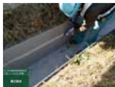
内面ライニング施工状況
