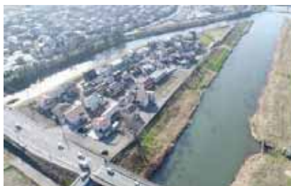
平成28年熊本地震による宅地の液状化被害
