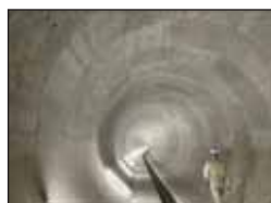
雨水貯留管内部 (仕上がり内径φ5,250mm)
