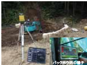
MGバックホウによる掘削
