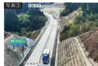
▲写真③ 山都中島西IC～山都通潤橋IC 開通後の状況（R6.2）
