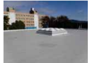
図書館・特別研修棟(防水工事完成後)
