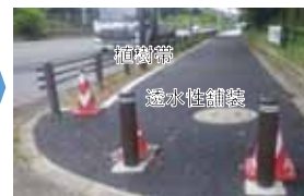
【対策後】 雨水貯留浸透機能の確保
