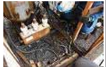
廃墟にて発見された高濃度PCB含有コンデンサー
