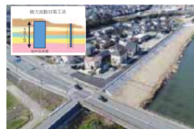
液状化対策（側方流動対策工法）
