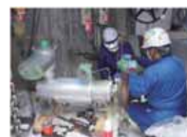
処理施設における補修作業
