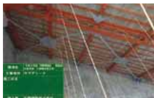
対策後(屋根のブレース補強:令和5年3月対策完了)
