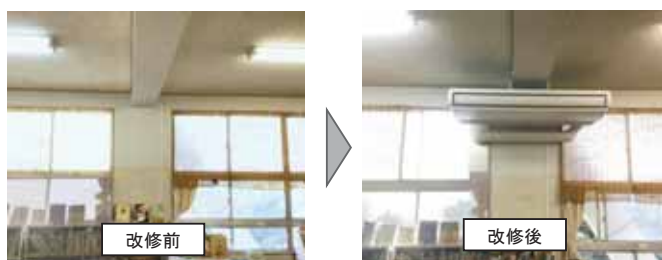
【特別教室空調設備設置事業の事例(神奈川県南足柄市)】
