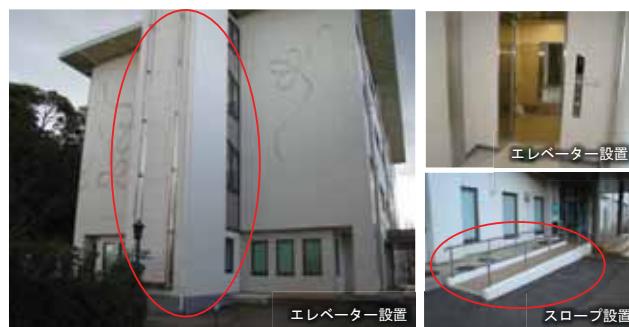
エレベーター設置
