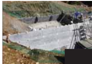
残存型枠を用いた砂防堰堤施工
