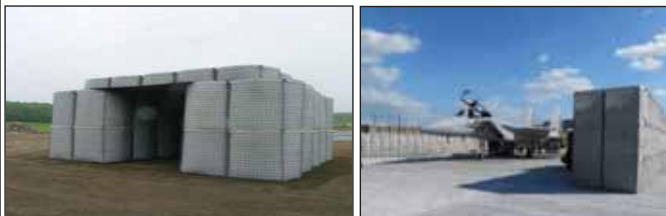
【簡易防護壁(箱型土のう)】
