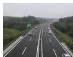
⑤ 三陸北縦貫道路
