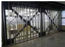
西館 2階教室内壁補強工事
