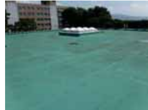
図書館・特別研修棟(防水工事着手前)
