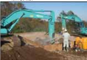
現場発生材を使用した砂防ソイルセメント工法による打設
