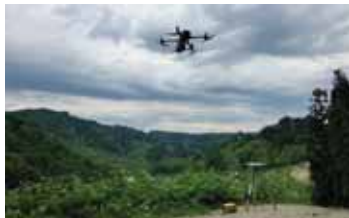
UAVによる起工測量
