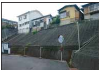
対策前の大規模盛土造成地
