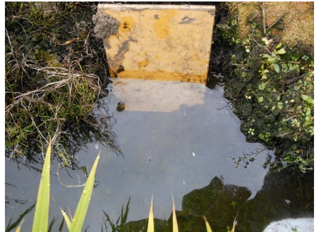
【止水板による止水状況】
