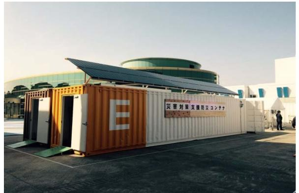
【ソーラー発電を備えた災害時電源設備コンテナ】
