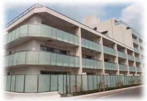
【耐震補強工事施工後】
