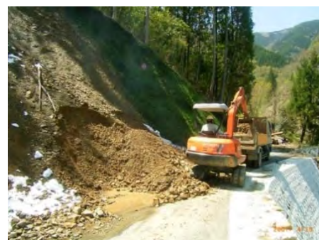
【土砂崩れ現場での作業】
