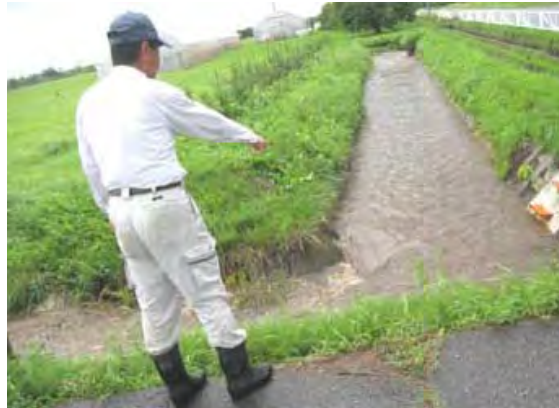
【異常気象時（大雨時）の点検・確認】
