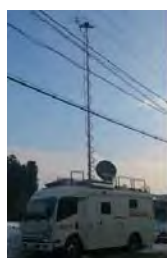
【移動基地局の設置】
