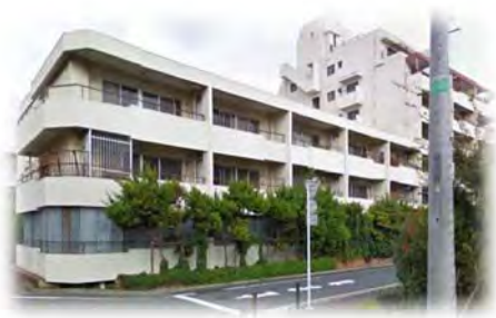
【耐震補強工事施工前】
