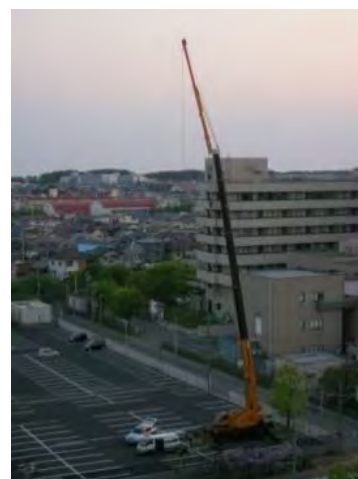
【クレーン車で空中線設置】
