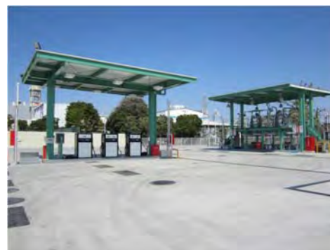
【杉戸燃料備蓄基地の外観】
