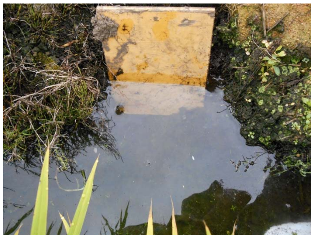
【止水板による止水状況】
