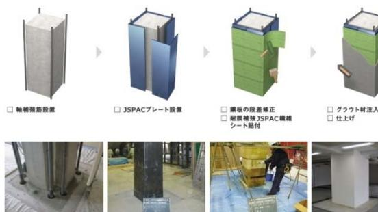
【耐震構造の比較と JSPAC 耐震工法の施工の様子】
