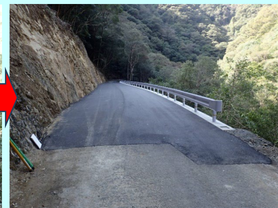
林道対策工事完了後 (R5)
