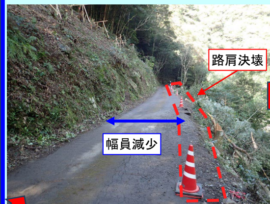
林道対策工事实施前 (R4)
