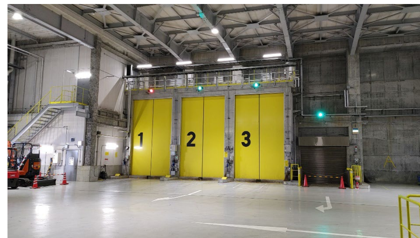
長岡市中之島新ごみ処理施設(仮称):内観
