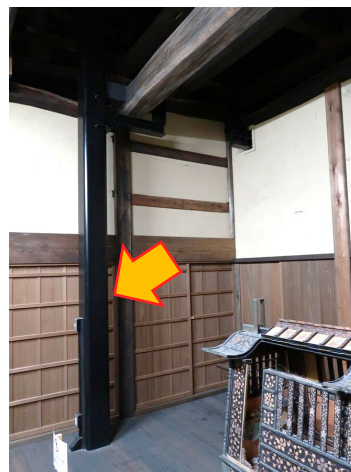
国宝大広間及び式台: 鉄骨フレームによる補強の結果、被害なし
