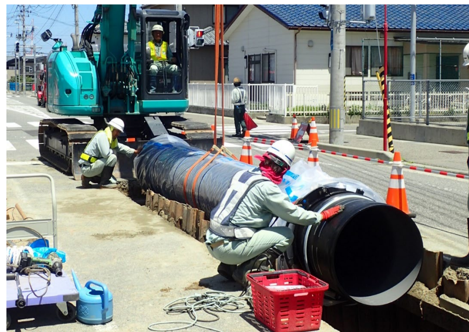
ダクタイル鋳鉄管(耐震継手(NS型)、管径700mm)布設工事
