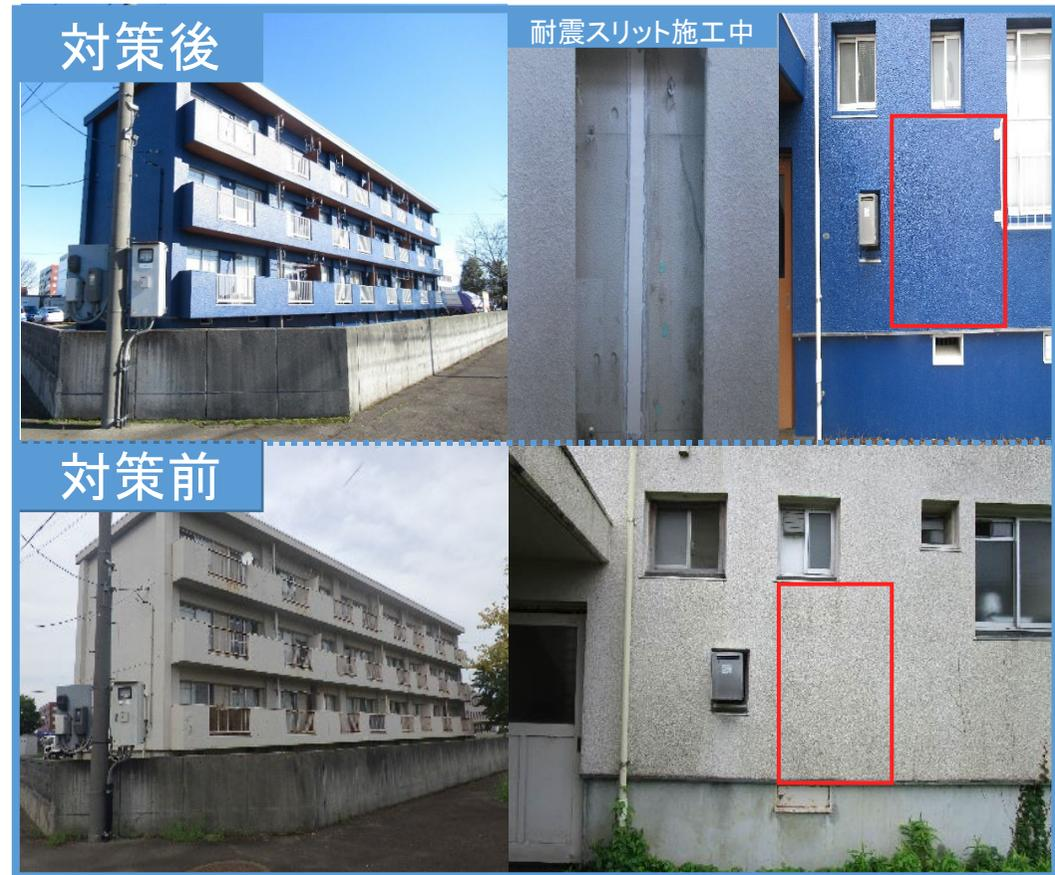
※耐震スリット・・・ 壁と柱又は梁を切り離すことにより、柱の靱性を向上させることで耐震性を向上させる工法
