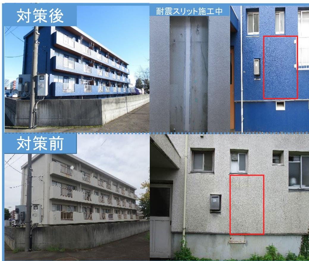
※耐震スリット・・・ 壁と柱又は梁を切り離すことにより、柱の靱性を向上させることで耐震性を向上させる工法
