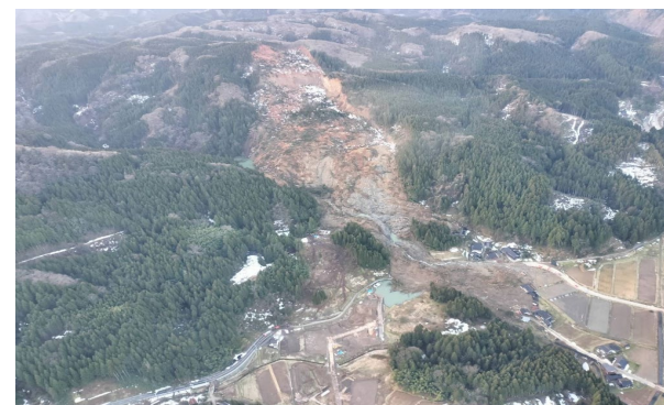
災害現場の被害状況確認(愛知県大隊)
