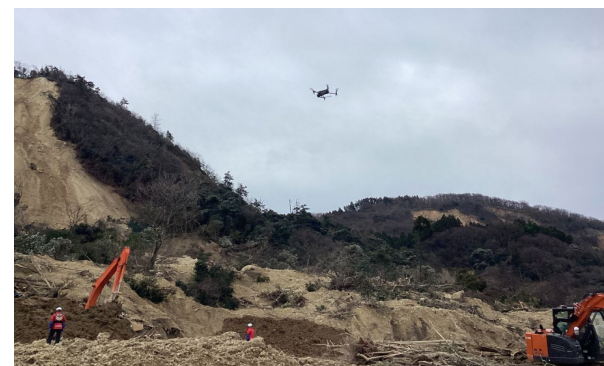
災害現場の被害状況確認(長野県大隊)
