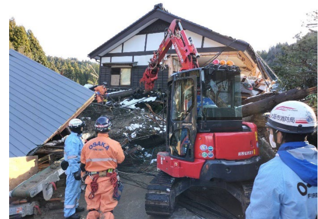
○重機で土砂排除【大阪府大隊】
