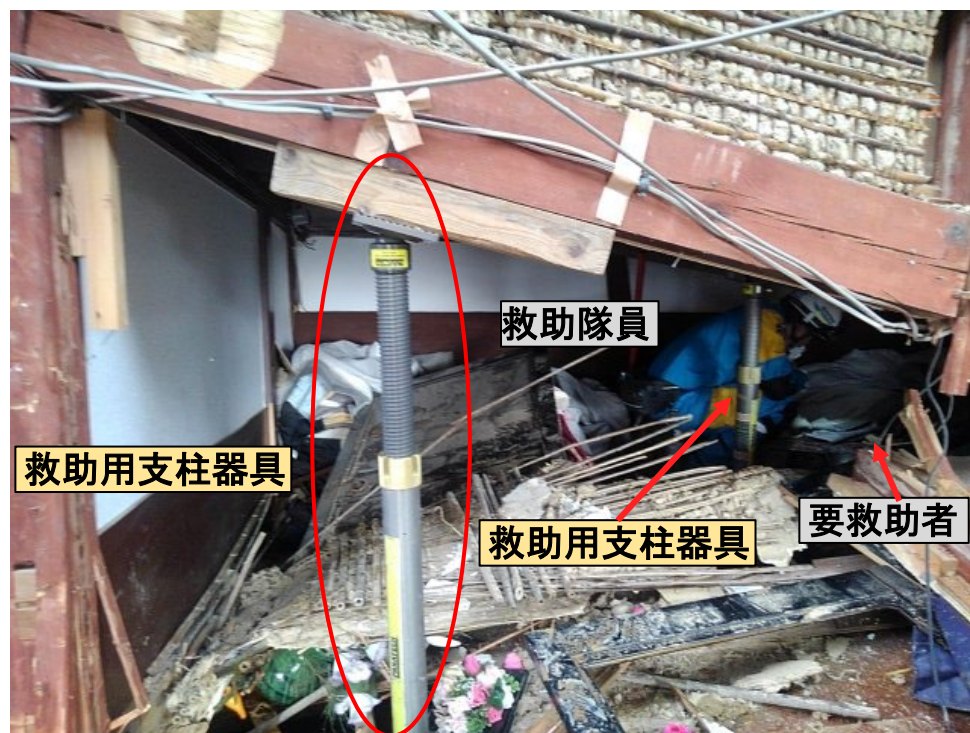
救助用支柱器具(レスキューサポート)を使用した救助活動
