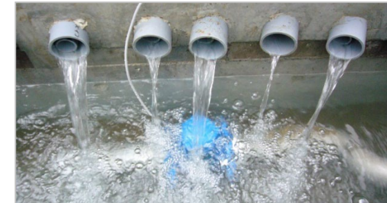
横ボーリングの排水状況
