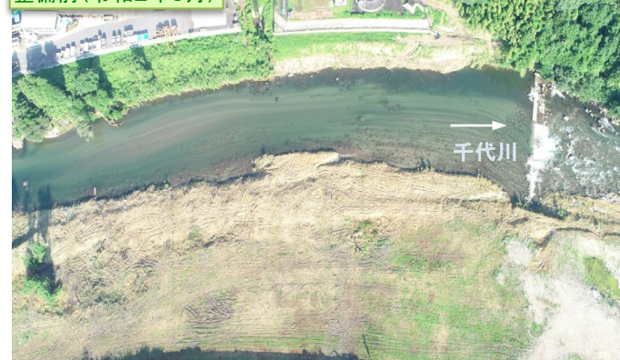
整備前(令和2年3月)
