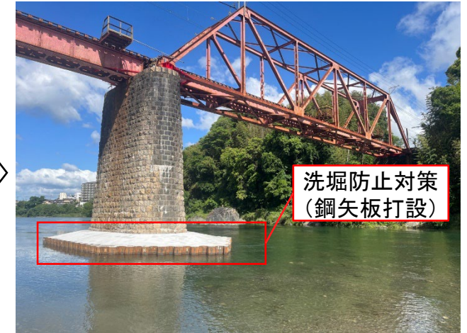
橋脚の洗掘防止対策を実施
