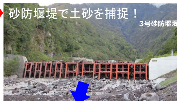
土石流発生後(令和5年9月29日 撮影)
