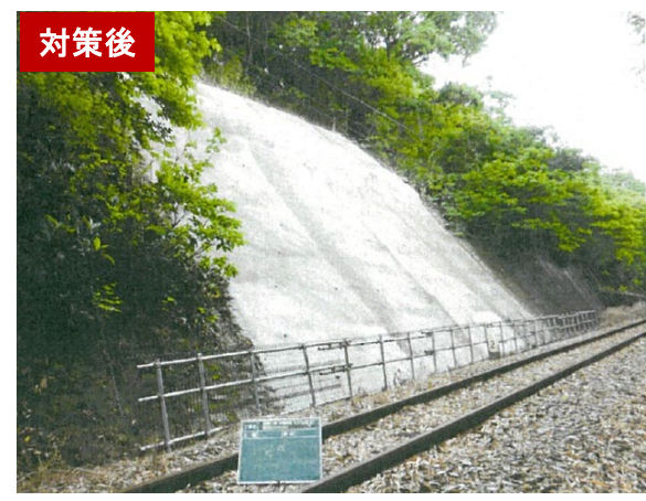
コンクリート吹付による法面固定
