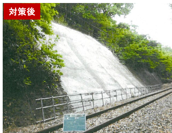
対策後 コンクリート吹付による法面固定
