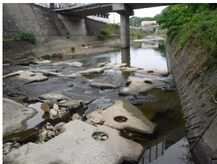
護床ブロック散乱・流出
