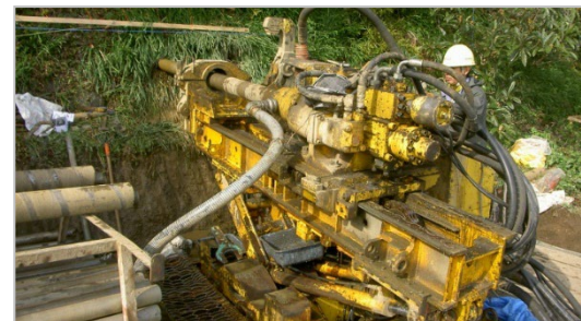
横ボーリングの施工状況
