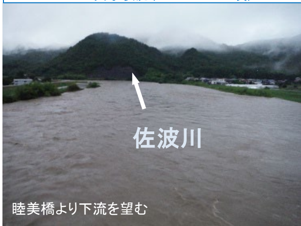
出水状況(R5.7.1 5:00頃)
