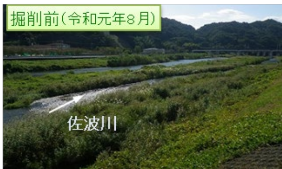
上右田地先整備状況(9k000付近)
