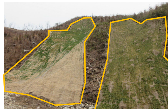
山腹工の実施状況(斜面下部から望む)
