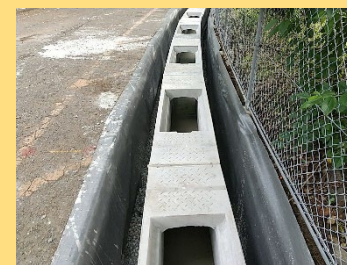
新設した浸透側溝
