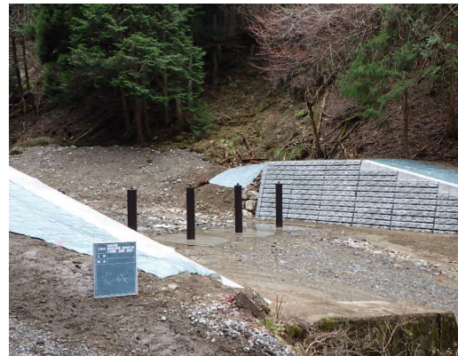
5か年加速化対策により設置した流木止工
