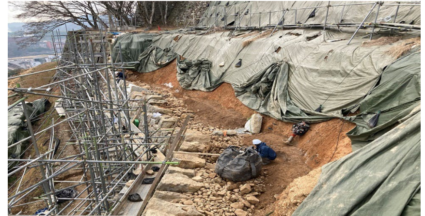
老朽化対策工事
