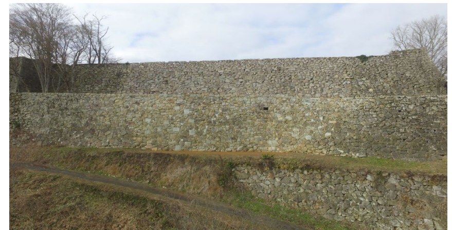
老朽化対策工事完了
