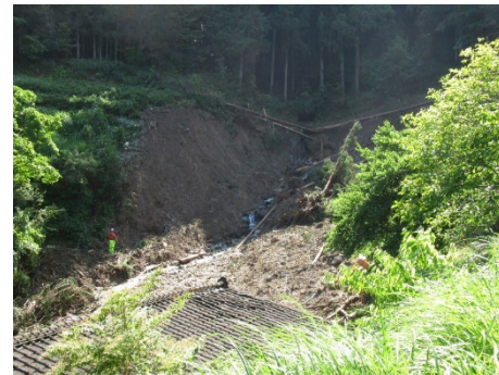
土砂災害現場
