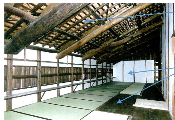
二階楽屋 補強完了後
