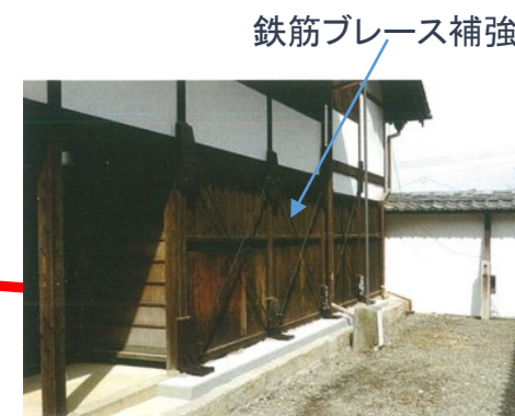
鉄筋ブレース補強 側面外壁 補強完了後
