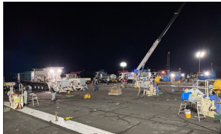
〔滑走路の耐震対策 施工状況〕
