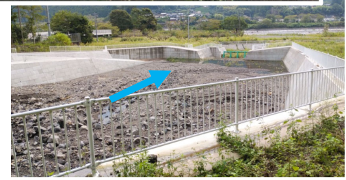
ビワミズ沢沈砂地工 完成 令和3年11月 堤長 L=88.5m 堤高 H=3.0m
