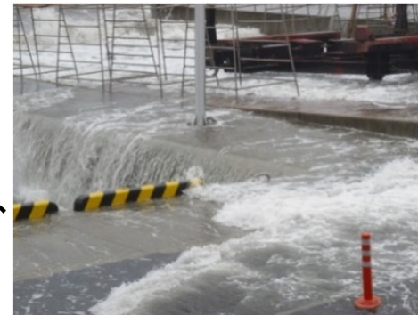
越波による浸水(平成23年台風12号)
