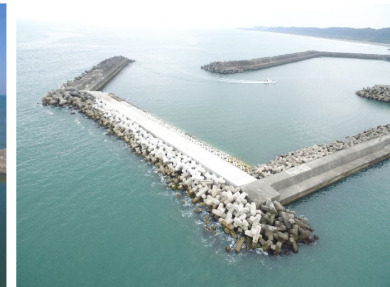
防波堤(新設、粘り強い化)
