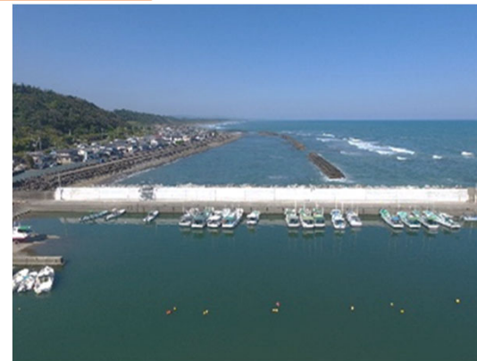
北防波護岸(改良、かさ上げ)
