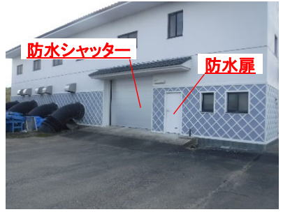
排水機場建屋の耐水対策
