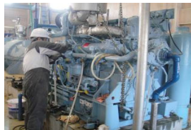
ポンプの復旧状況
