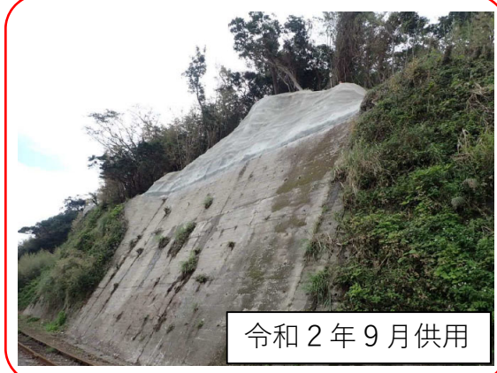
法面対策を実施した結果、被害なし (令和3年8月豪雨)
