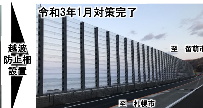
3か年緊急対策による越波対策
