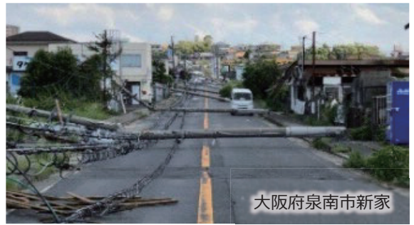
【倒壊した電柱で塞がれてしまった道路】 （H30年 台風21号による被害）
