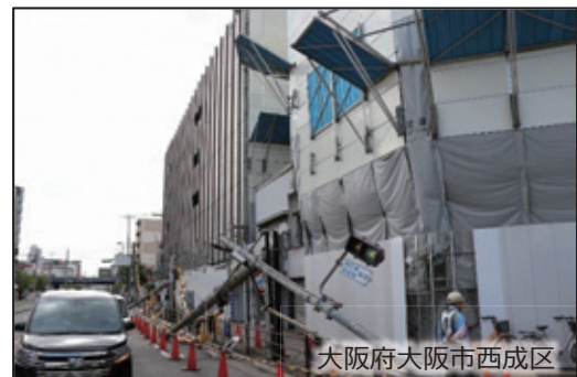
【H30台風21号による電柱倒壊の例】
