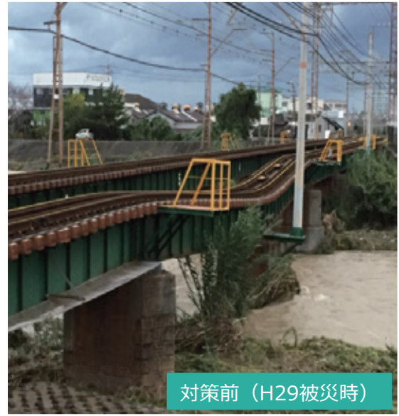
南海本線 男里川橋梁 (橋脚の洗掘対策を実施)
