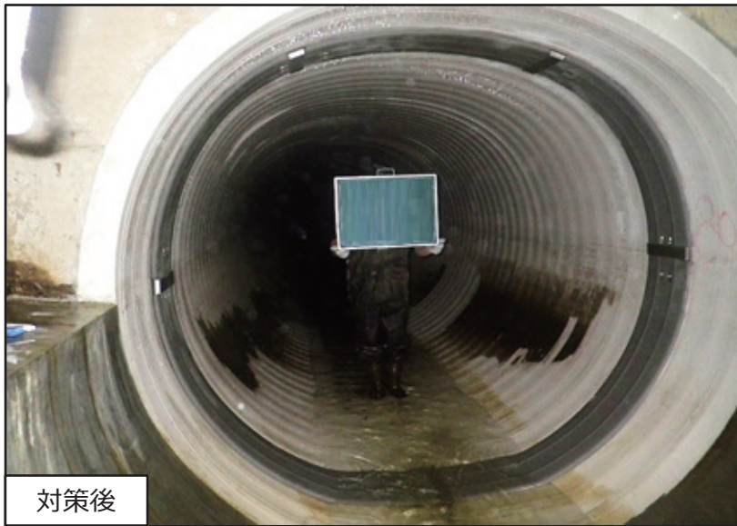
千葉市美浜区の下水道管渠施設の耐震補強
