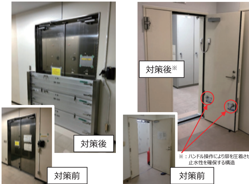
電源設備等が設置された部屋に止水扉や止水板を設置
