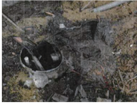
風水害による破損のリスク
