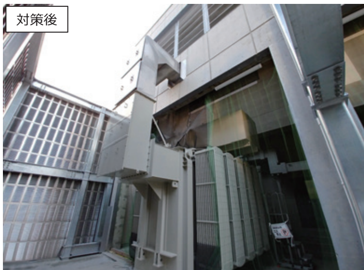
特高受変電設備（電気を変圧し、京都大学の中央団地と北部団地に供給）
