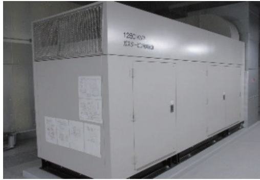
冷蔵施設に非常用電源を整備
