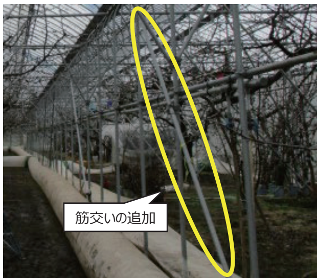
農業用ハウスの補強対策実施済み
