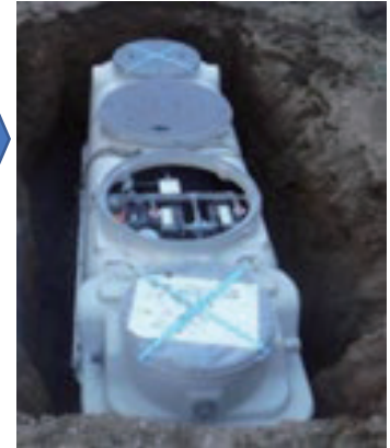
合併処理浄化槽への転換
