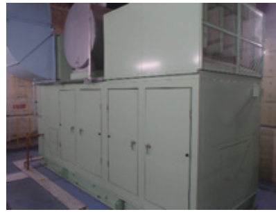
非常用発電設備の設置
