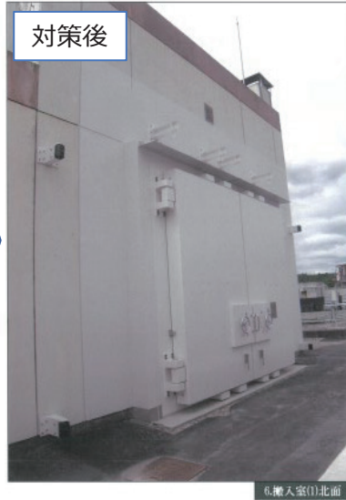
浸水対策（水密化）を実施した田口浄水場管理棟（ポンプ棟）
