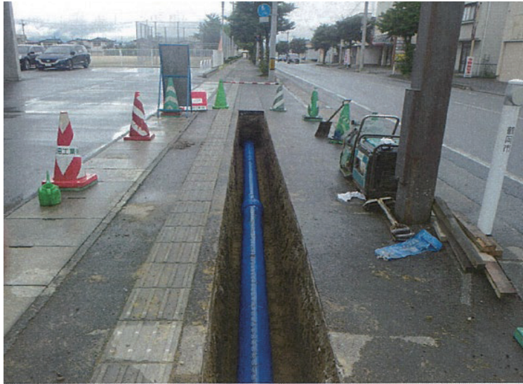
基幹管路を耐震性を有する管路へ布設替
