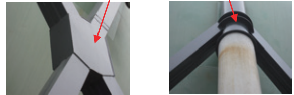
球形貯槽を支える脚部の補強対策
