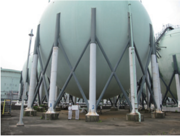
球形貯槽（耐震補強前）
