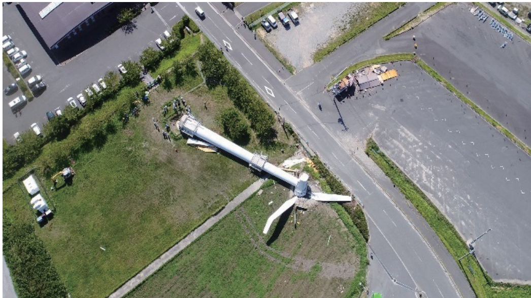
台風による強風で倒壊した風力発電設備
