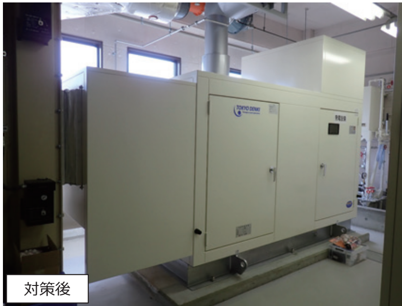
盛岡地方気象台に整備した自家発電設備
