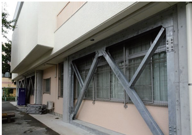
写真：耐震補強工事後
