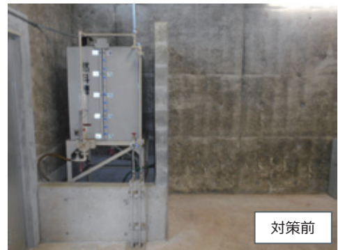
予備発電設備燃料タンク（改良前）
