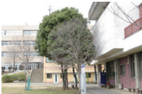
写真：耐震補強工事前
