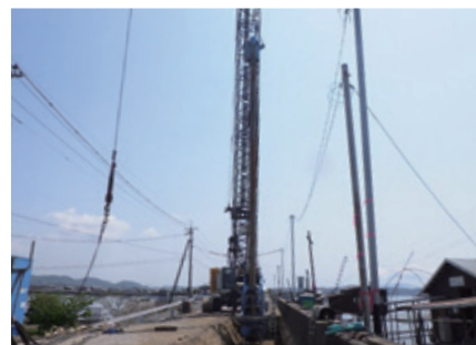
耐震化に必要な鋼矢板の打設状況
