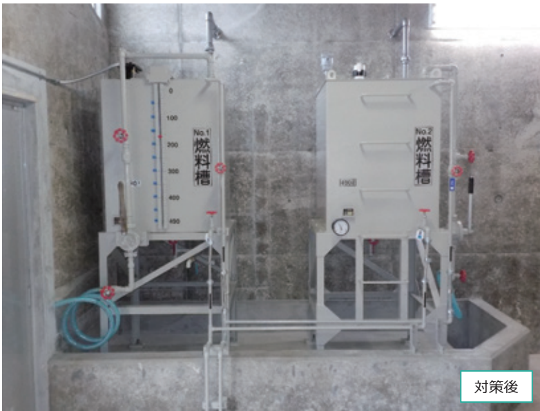
予備発電設備燃料タンク（改良後）
