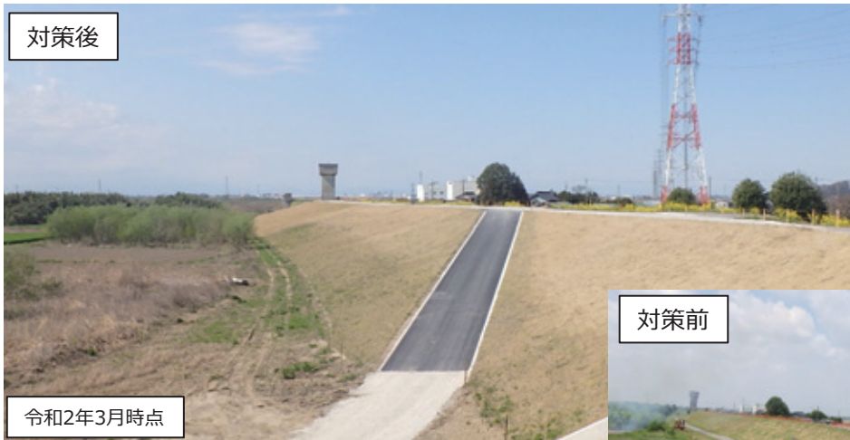
渡良瀬川の堤防（堤防断面の拡幅を実施）
