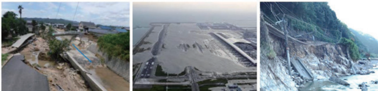
平成30年の災害の様子 出典：「防災・減災、国土強靱化のための3か年緊急対策」特集サイト（内閣官房）
