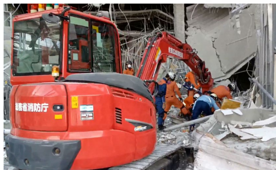
イオンモール熊本で重機を 活用し救助活動を実施
