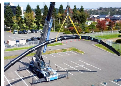
耐震型ダクタイル鉄管採用50周年セミナー (新耐震管GXφ500吊り上げ)
