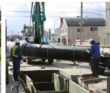
耐震管の布設工事
