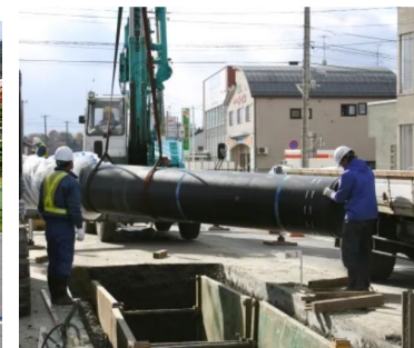
耐震管の布設工事
