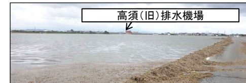
※排水受益から高須(旧)排水機場を望む
