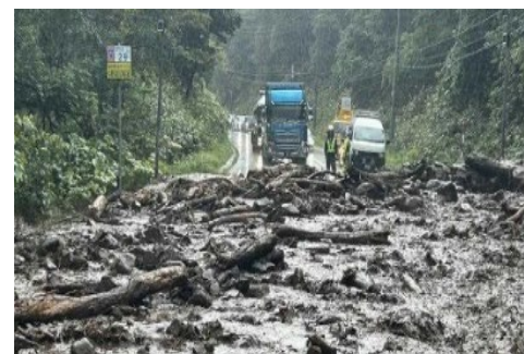
(写真1) 国道227号土砂流入状況(R7.8.19)
