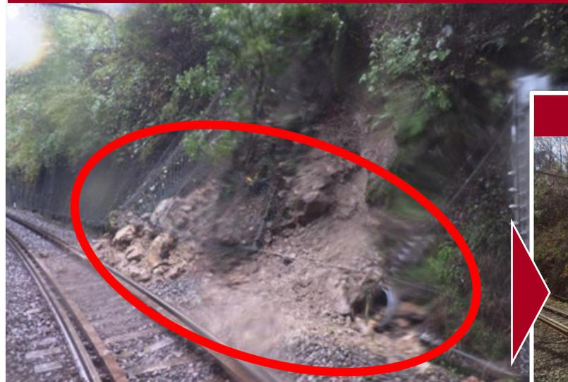
令和元年台風第20号では崩落した土砂の線路流入があったが、同程度の雨量となった令和6年台風第10号では対策による効果で線路流入を防止した。
