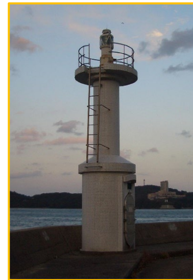
▲配電線堤上埋設
