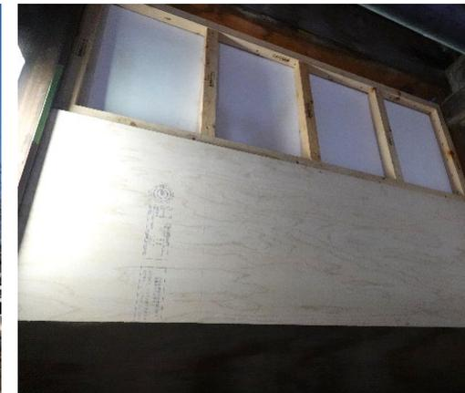
土壁位置での構造用合板補強
