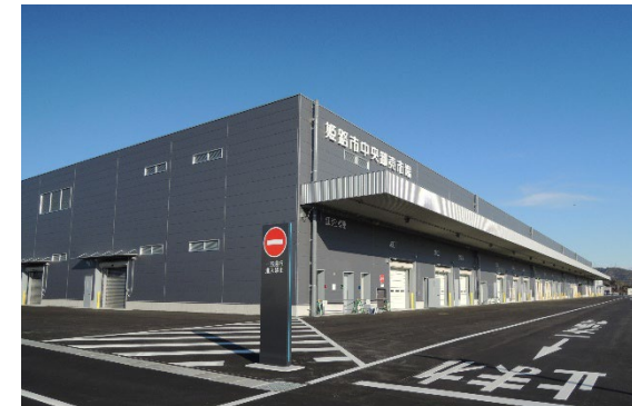
耐震化した施設
