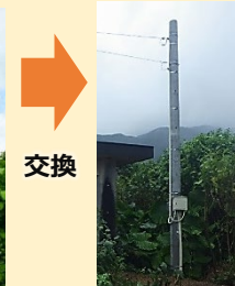
コンクリート柱
