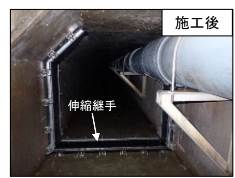
土木施設の耐震補強工事(伸縮継手の設置)状況
