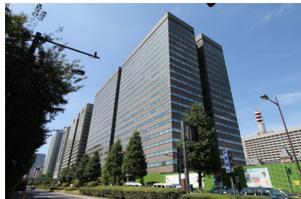
建物外観(A棟)
