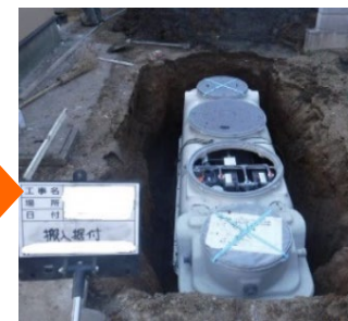
合併処理浄化槽設置
