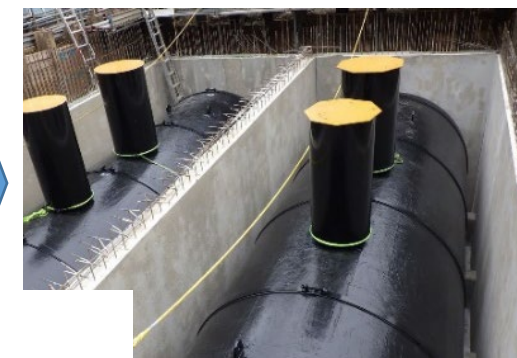
燃料槽設置後
